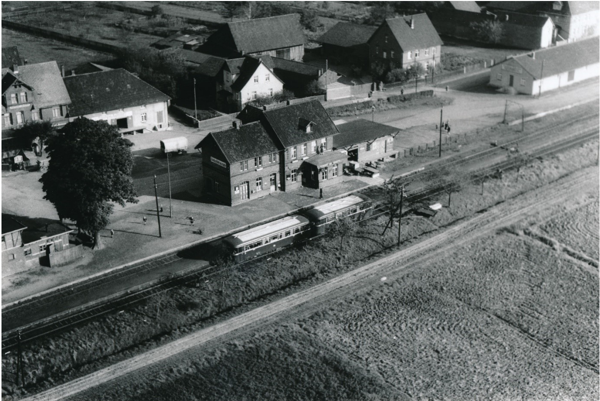
Luftbild vom Bahnhof Gieboldehausen am 13.10.1956
