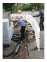
Beim Breitbandausbau der Telekom in der Samtgemeinde werden von der Vermittlungsstelle "Am Schützenplatz" nicht nur Glasfaserkabel zu den 21 Verzweigerkästen im Flecken und 9 in Bilshausen verlegt. In Gieboldehausen werden ferner Glasfaserkabel zu einem Dutzend Kabelverteilern mit Multifunktionsgehäuse verlegt und neun weitere über neue Kupferkabel mitversorgt.
